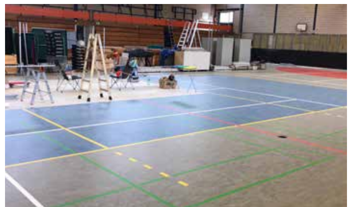
neuer Hallenboden mit Linien
